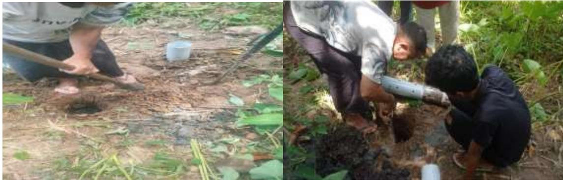
**Gambar 3.** Melakukan survey lapangan dan melakukan pemasangan pipa biopori menggunakan alat penggali tanah, dengan partisipasi masyarakat lueng jawa.
