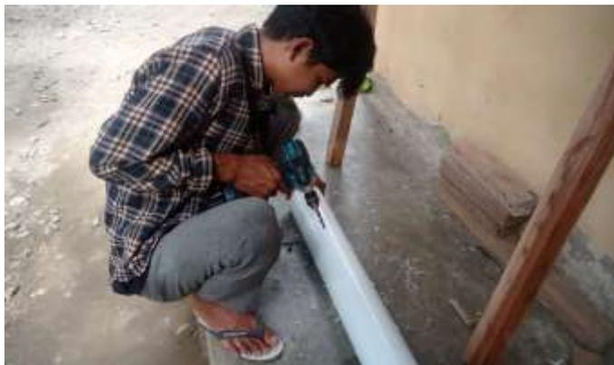
**Gambar 2.** Pembuatan pipa biopori
