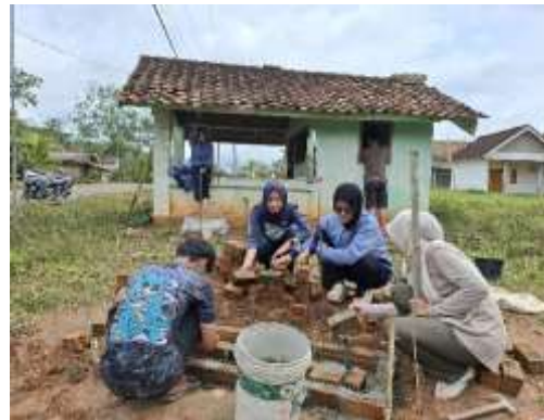
Gambar 3. Proses pembuatan fondasi tugu
