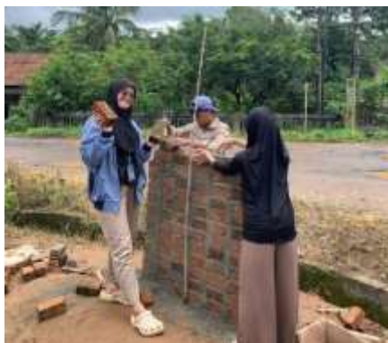
Gambar 2. Proses Pembangunan tugu
