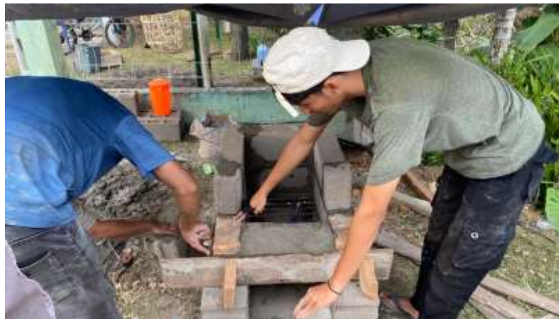
Gambar 2. Proses Pembuatan Rocket Stove
