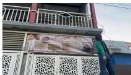
Gambar 19. Proses pemasangan Spanduk
