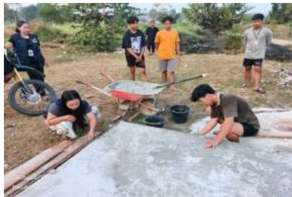
Gambar 1. Proses pembangunan Tempat Pembuangan Sementara (TPS) di lingkungan Pasar Pandohop
