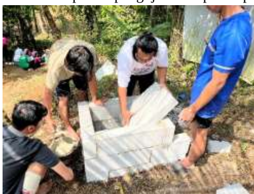
Gambar 2. Proses pembuatan roket stove
