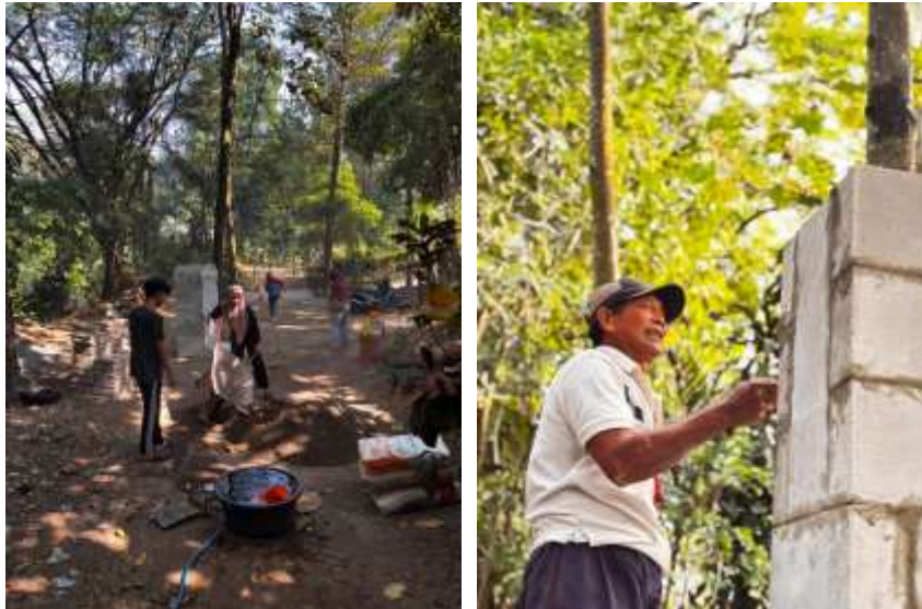
Gambar 3. Proses pembangunan incinerator bersama warga setempat
