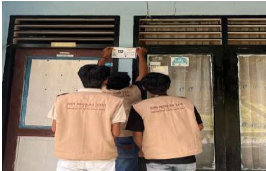
Gambar 2. Pemasangan Nomor Rumah
