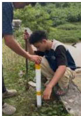
Gambar 5. Proses pemasangan reflektor sekitar jembatan
