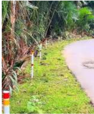
Gambar 6. Proses pemasangan reflektor sekitar balai desa
