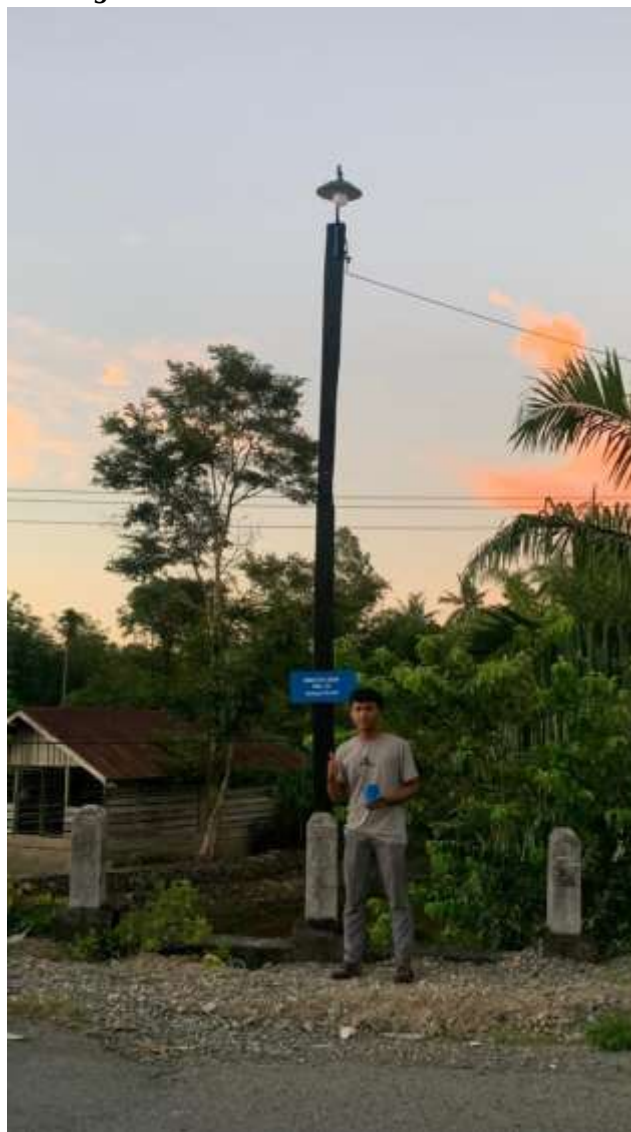
Gambar 8. Kondisi PJU setelah pemasangan pada siang hari.
