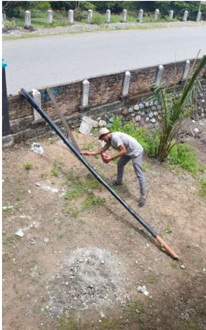
Gambar 6. Fondasi penyangga instalasi PJU.
