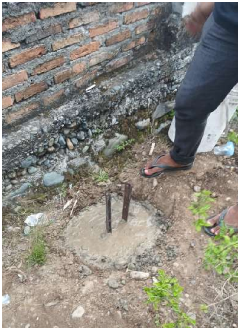
Gambar 5. Penyiapan dan pemasangan penyangga instalasi PJU.
