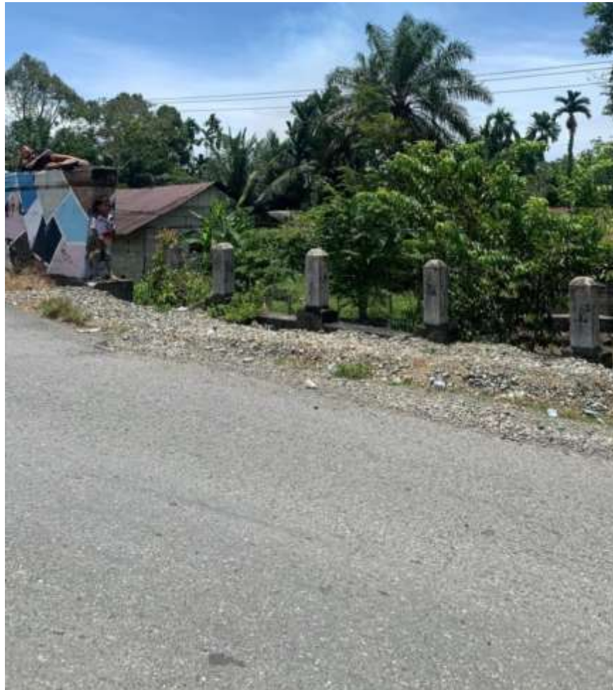
Gambar 4. Kondisi jalur transit sekitar jembatan sebelum pemasangan PJU.
