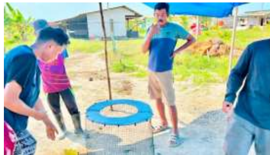
Gambar 14. Pembuatan Lubang pada Bagian Atas sebagai Akses Memasukkan Sampah
