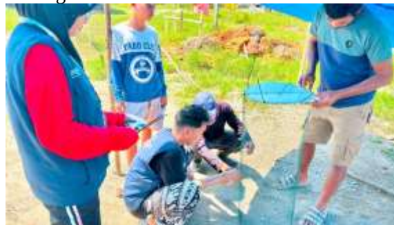
Gambar 11. Pembentukan Jaring Besi Menjadi Rangka Berbentuk Tabung
