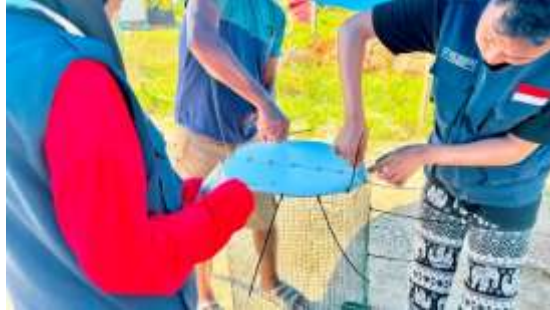
Gambar 13. Pengaitan Infraboard pada Rangka Jaring Besi Menggunakan Tali Sigma
