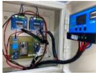
Gambar 3. Instalasi dan Pengawatan Komponen (Sumber: Hasil Olah Data Peneliti (2026))
